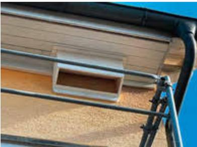
*Abb. 3: Der bereits eingebaute 6-Kammerkasten, er ragt mind. zur Hälfte in den Dachkasten hinein (Foto: Klaus HECK)*
