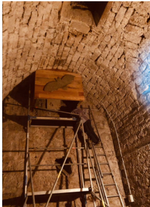
Wärmekammer Schlosskeller Tübingen nach neuer Auskleidung mit Heraklithplatten innen und Deko außen (Foto: I. Kaipf)
