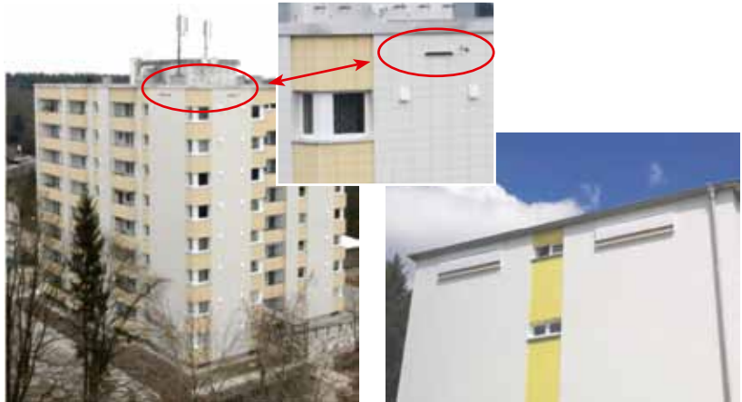
Abb. 7: Abendseglerersatzquartiere in Waldkraiburg. Einbau in eine Fassade (links), Anbringung von Kästen (rechts). Fotos: A. Zahn
